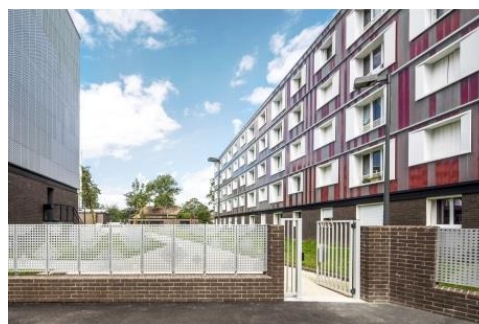
Réhabilitation et résidentialisation de 90 logements collectifs - Le Havre (76)
