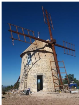
Restauration du moulin à vent de la Borie - Hures-la-Parade (48) © Bousquié Christophe
